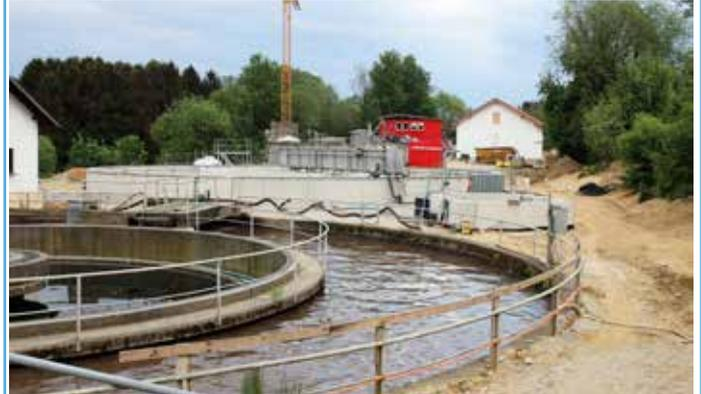
Die Sanierung der Kläranlage geht dem Ende entgegen. Aktuell wird das alte Regenrückhaltebecken abgestrahlt und dann saniert. Das erste große Belebungsbecken ist bereits fertiggestellt. Im nächsten Schritt steht das Umpumpen aus dem alten Becken an, damit dieses saniert werden kann. Am Gebäude sind noch Restarbeiten zu erledigen.
